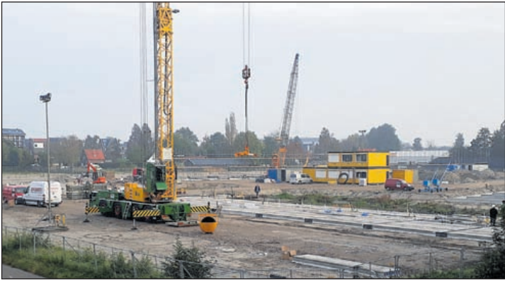
Nieuwbouw in Polderzoom in volle gang.
