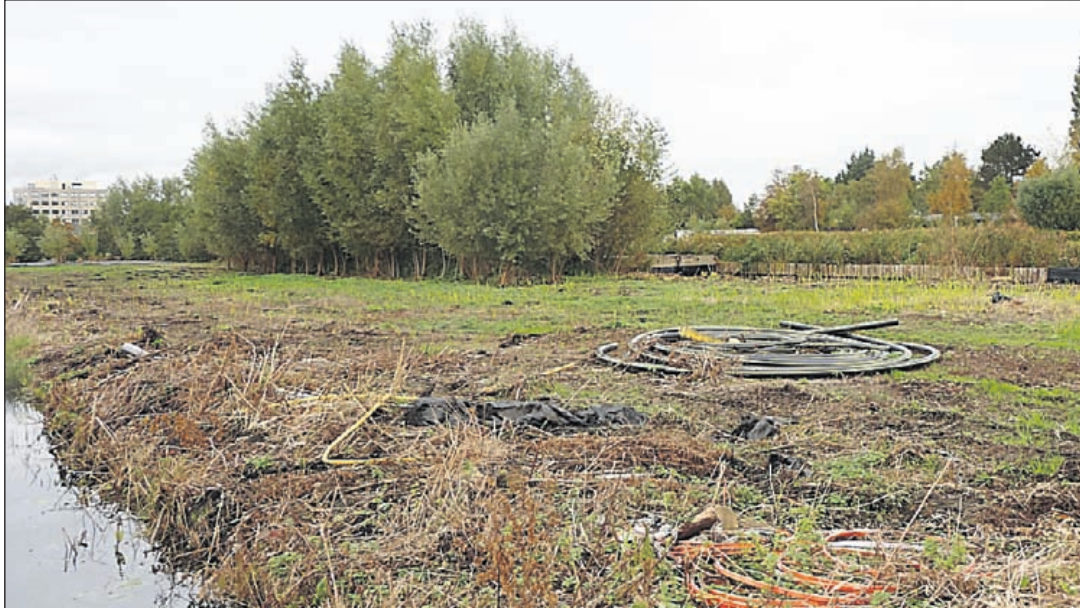
Kabels en leidingen gaan vanaf 2016 niet meer de grond in voordat hiervoor aan de gemeente betaald is.
