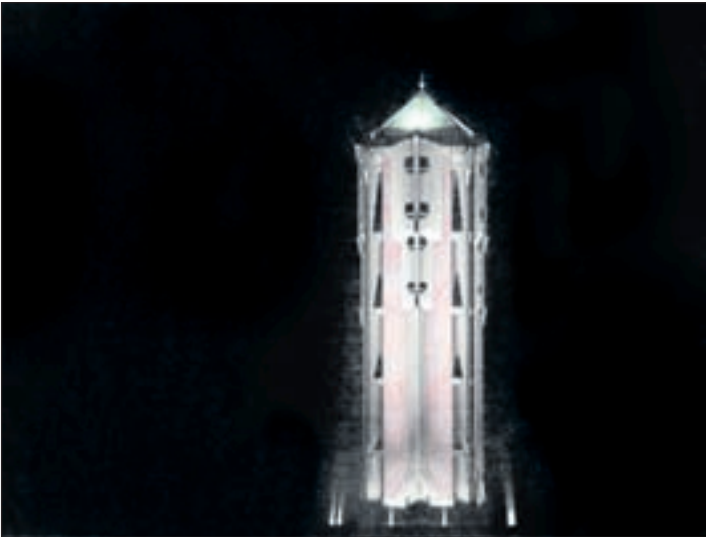
Het koperen dak eindelijk verlicht... Aanstaaende zaterdag een feit!
