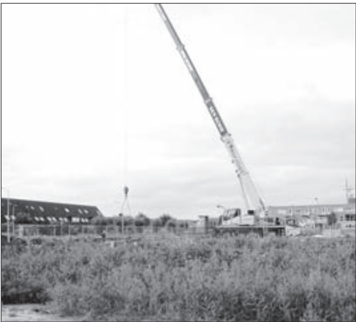
Bouwactiviteiten aan de Bilderdammerweg. In totaal komen er 75 woningen.
