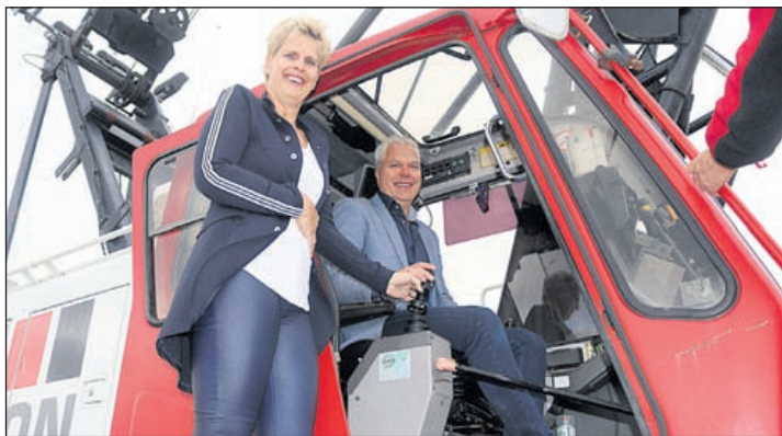
John en Ingrid Celie plaatsen de eerste van de in totaal 200 betonkolommen voor de nieuwbouw van Groenland 2.0
