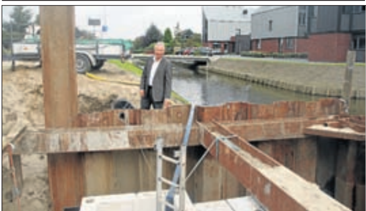
Wethouder A. Verburg van verkeer neemt een kijkje bij de laatste werkzaamheden voor de duiker in de Mijnsherenweg.
