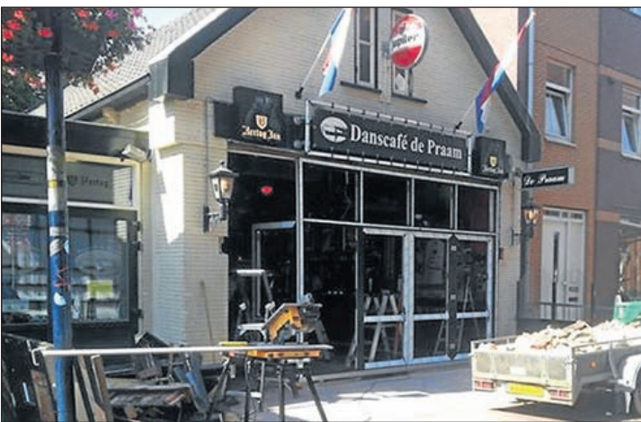
De nieuwe schuifpui aan de voorzijde in de Zijdstraat van café de Praam.
