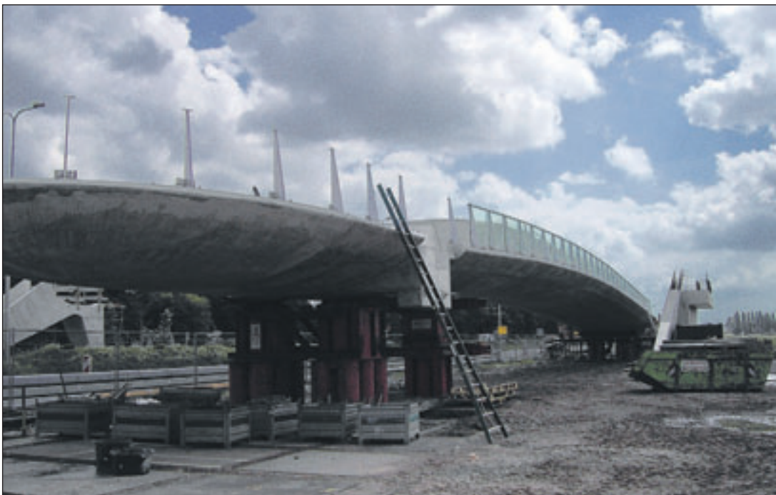
De nieuwe fiets- en wandelbrug is een bijzonder stukje werk. Nadat het houten 'karkas' gereedkwam is de opbouw gerealiseerd. In het weekend van 16 en 17 augustus komt het 'gevaarte' over de N201 nabij de kruising met de Aalsmeerderweg.
