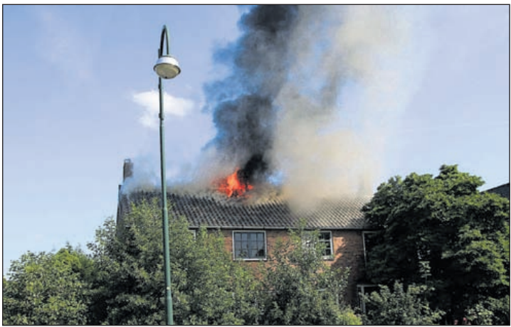
Grote vlammen uit het dak van de woning. Foto: Marco Carels
