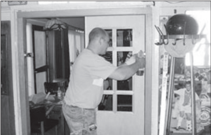
In Café Sportzicht scheiden gloednieuwe klapdeuren, die hier door aannemer W. Groen gemonteerd worden, de gelagkamer van het zijlokaal. Daar mag gerookt worden. Er mag in de rookruimte echter niet worden bediend. (Eigen foto)
