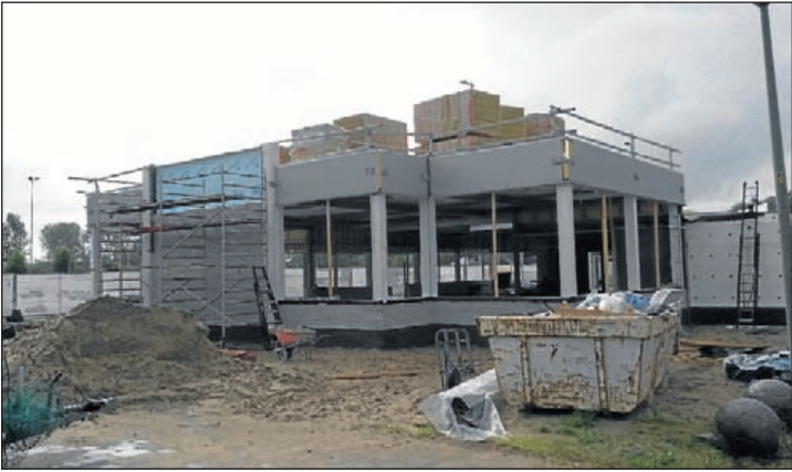
De bouw van de kantine op het sportcomplex van FC Aalsmeer vordert.
