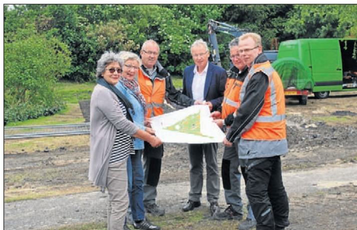
Wethouder Beheer Ad Verburg en leden van werkgroep Seringenpark krijgen uitleg over de werkzaamheden.
