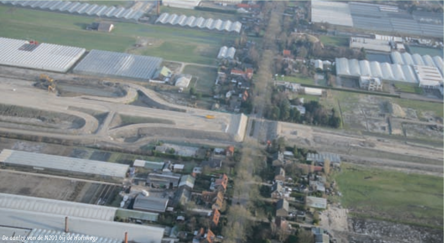
De aanleg van de N201 bij de Hornweg.
