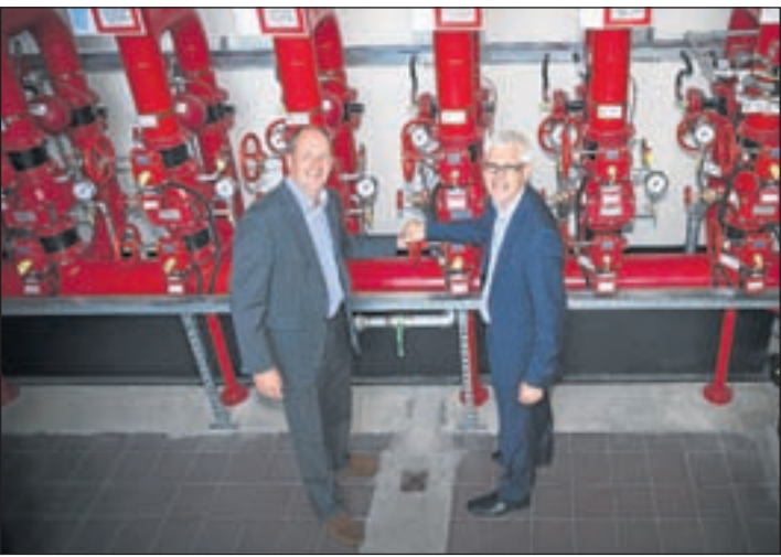
Marcel Claessen (vestigingsmanager FloraHolland Aalsmeer) en Alex Limburg (manager Facility Management FloraHolland Aalsmeer) openen de afsluiter van de nieuwe sprinklerinstallatie van bloemveiling FloraHolland Aalsmeer.
