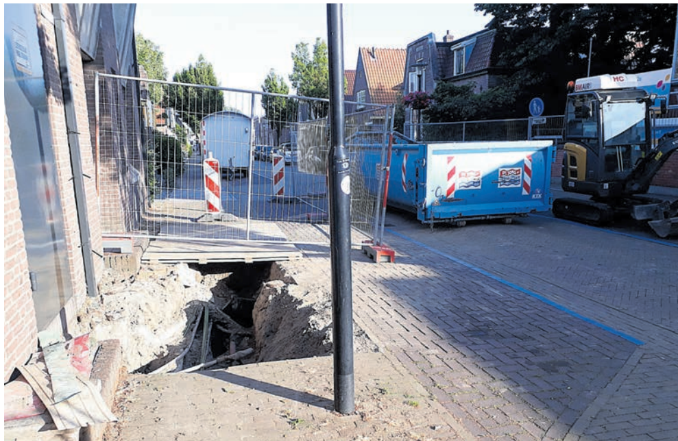
Het eerste graafwerk is verricht, maar het gat gaat nog groter worden. Alle elektriciteitskabels gaan afgekopeld worden van het PEN-huisje, waarin ook nog asbest gevonden is...
