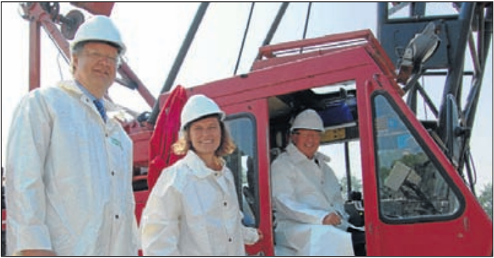
Jan Putman van Habion, Thelma van Petersen en Wethouder Ad Verburg (van links naar rechts) bij het slaan van de eerste paal van het project Mijsheerlyckheid in Kudelstaart.
