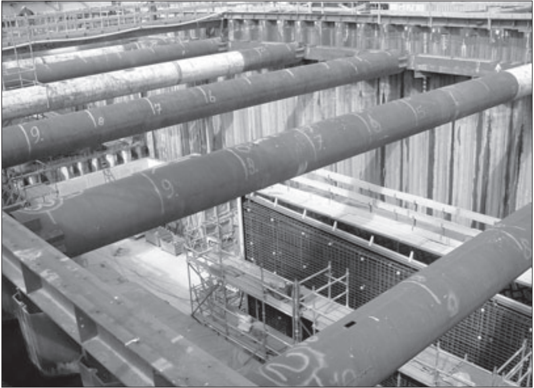
Op 17 april kon de pers al een kijkje nemen in de tunnel die gegraven wordt onder de Ringvaart. Dit onderdeel van de nieuwe N201 vormt een indrukwekkend staaltje techniek. Wilt u dat zelf gaan bekijken, dan bent u welkom tijdens de Dag van de Bouw op zaterdag 31 mei.
