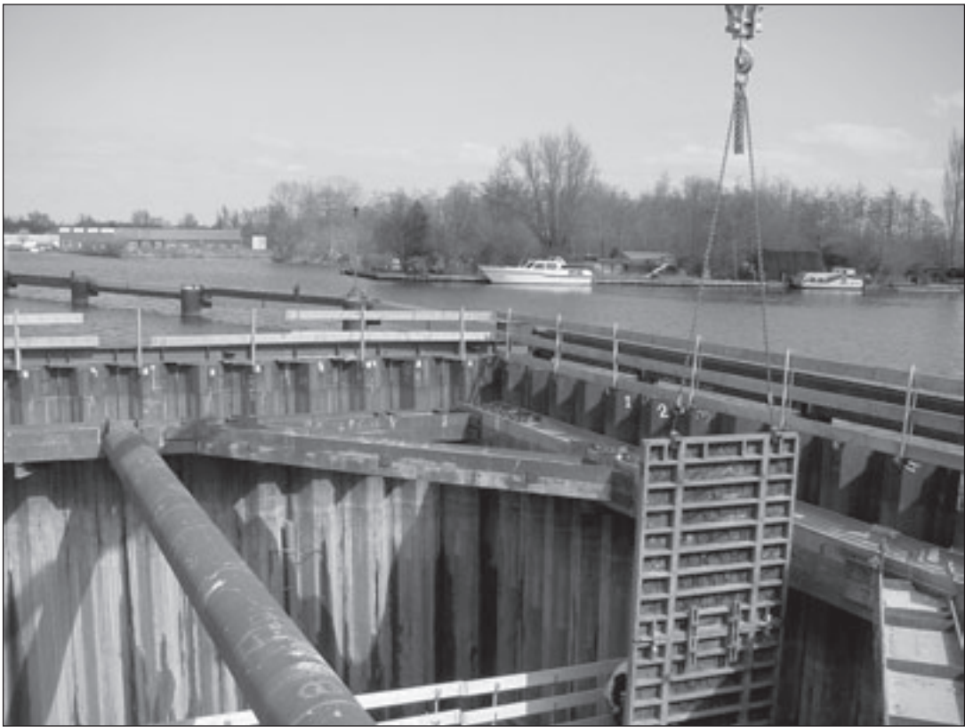
Rechts op de voorgrond brengt de kraan net een stalen wandpaneel de tunnel in. Foto's: Jacqueline Kristelij.
