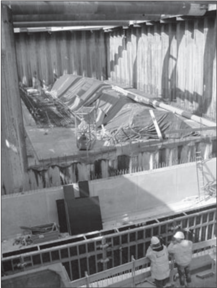
Rechts op de voorgrond brengt de kraan net een stalen wandpaneel de tunnel in. Foto's: Jacqueline Kristelij.
