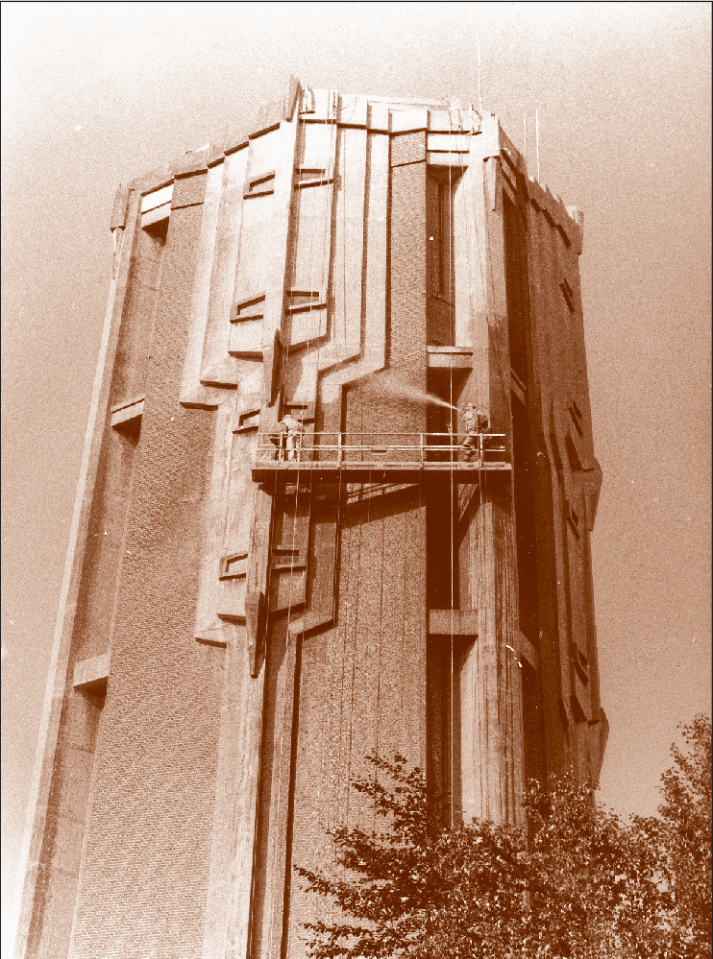
In 1988 werd ook al ‘geklust’ aan de buitenzijde van de watertoren. De mannen op de hangsteiger zijn met de hogedrukspuit bezig om de gevel te reinigen. Dit jaar zullen na de zomervakantie steigers tegen de toren worden geplaatst voor een algehele renovatie.
