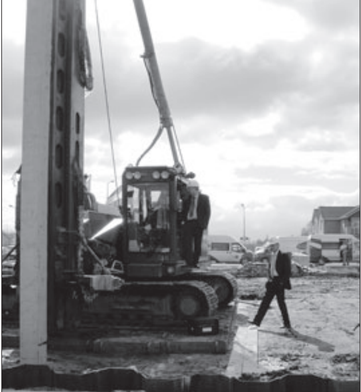
Wethouder Nijmeijer voordat hij plaatsnam om de eerste paal de grond in te boren
