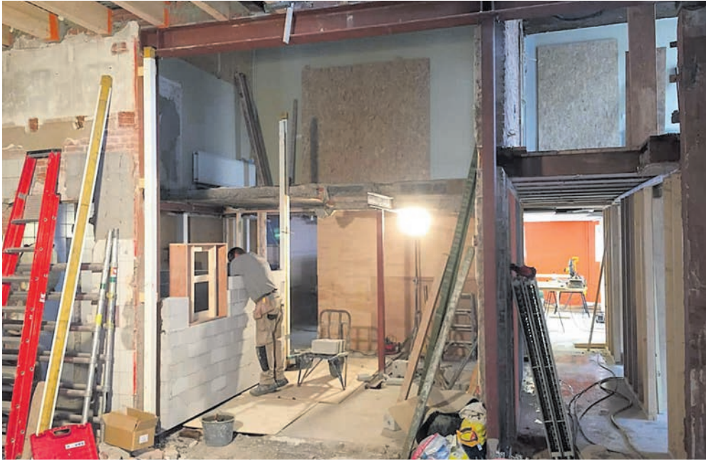
De verbouwing tot Huiskamer van Aalsmeer is in volle gang. Foto: ESA
