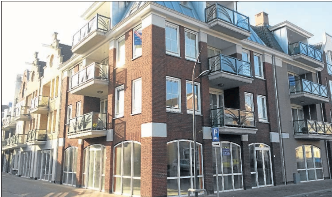
De nieuwbouw in de Zijdstaat, hoek van de Dorpsstraat. Straks ook bestemming kantoren voor deze winkels?
