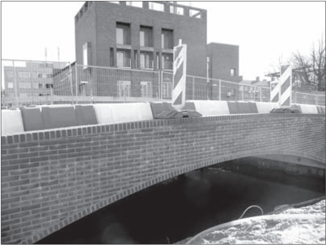
De brug over de Kerkwetering is voor de helft gereed. Een tip voor alle watersporters: Bukken bij het onderdoor varen! Foto: Jacqueline Kristelijn.
