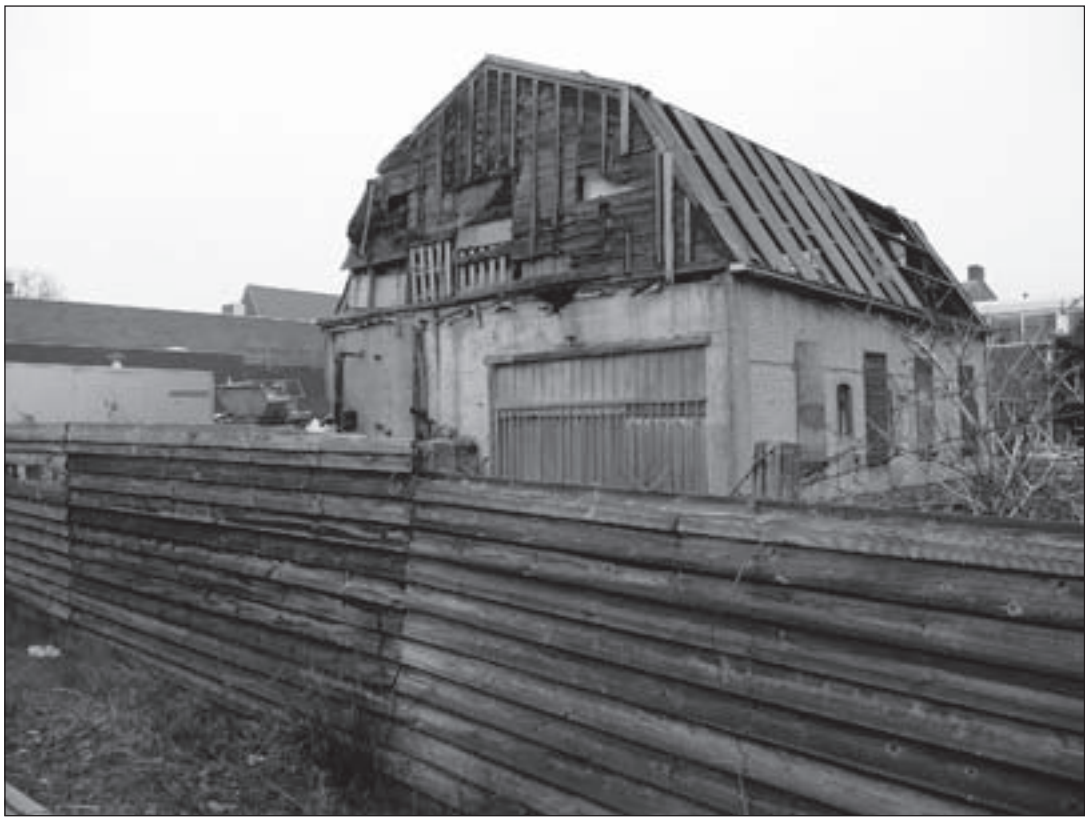
De oude schuur wordt momenteel afgebroken. Er is asbest aangetroffen. Mannen in witte pakken zijn gesignaleerd!
