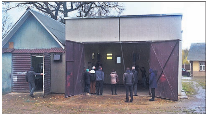
De beide garages. Eén ervan is in oktober klaar gekomen, compleet met een hydraulische hefinrichting om de onderkant van de auto's te kunnen repareren
