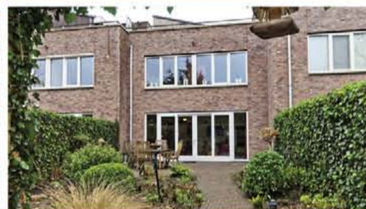
Maarse & Kroonhof Modern woonhuis met lift € 369.000,-
