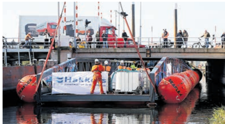
Veel bekijks bij het plaatsen van de fiets- en voetgangersbrug onder de Aalsmeerderbrug door. Foto: Bert Willems
