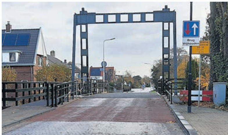
Barendsebrug 'schittert' als vanouds
