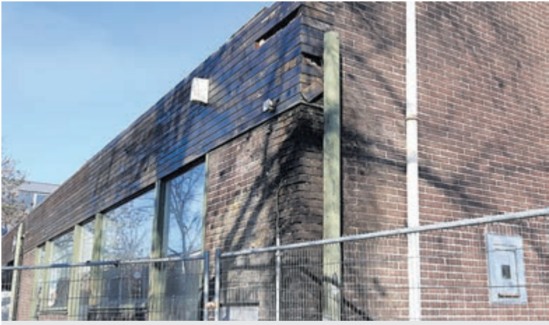
Sloop postkantoor aan de Stationsweg.
