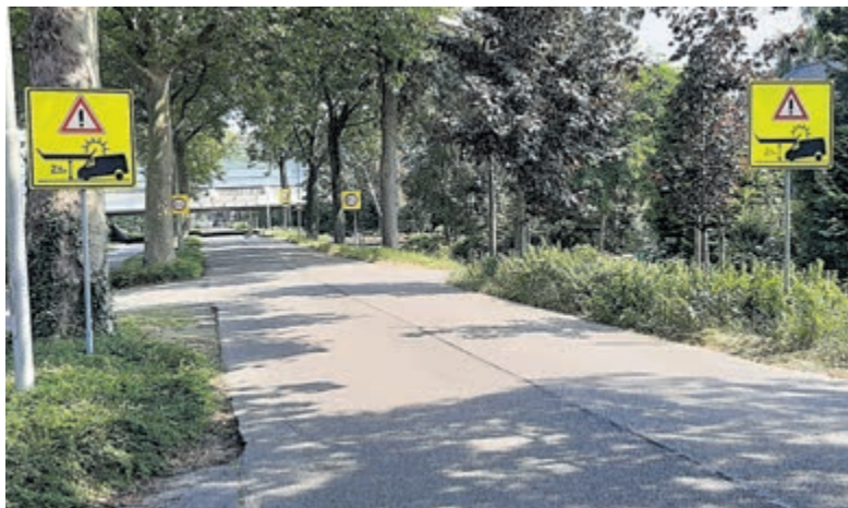
Extra waarschuwborden bij het (lage) viaduct van de Hornweg.
