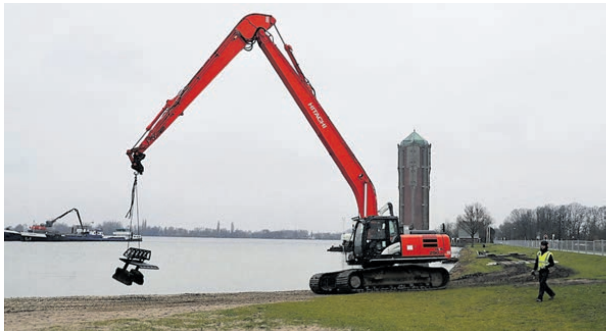
Werkzaamheden voor het Waterfront in volle gang. Foto's: www.kicksfotos.nl
