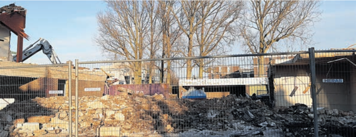
Het voormalige postkantoor wordt gesloopt. Op de achtergrond de negen bomen die gaan verdwijnen ten behoeve van de nieuwbouw.
