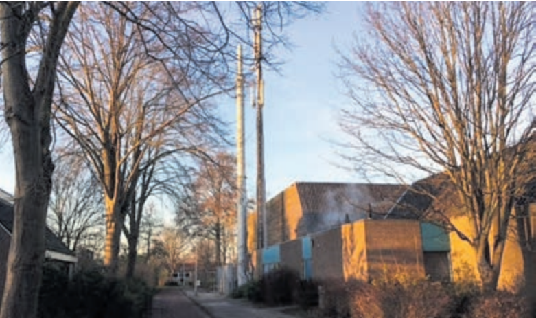
Opeens twee telecommasten? Oude mast verdwijnt zodra nieuwe in gebruik is.
