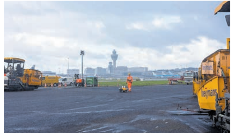
Baanonderhoud aan de Kaagbaan. Foto: Schiphol
