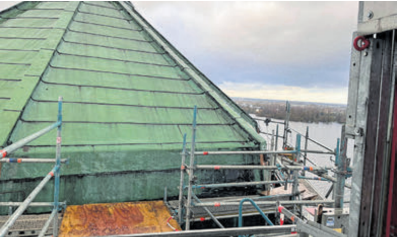
Het gerenoveerde dak van de watertoren. Foto: aangeleverd
