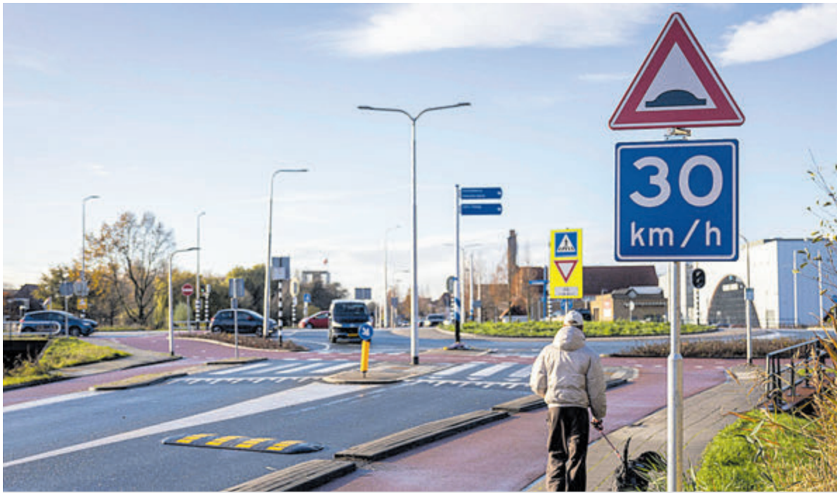
De nieuwe drempels en borden bij de rotondes op de Burgemeester Kasteleinweg. Foto: VLN Nieuws
