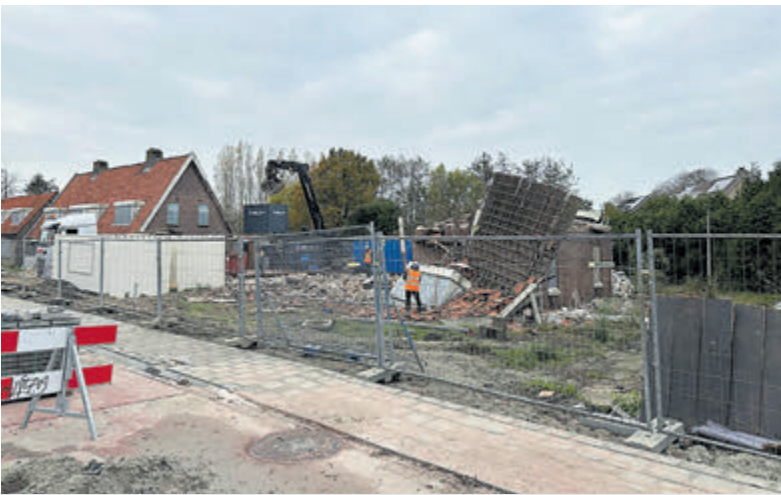
Woensdag 13 november is aangevangen met de sloop van de woningen aan de Bilderdammerweg. Foto: Joke van der Zee
