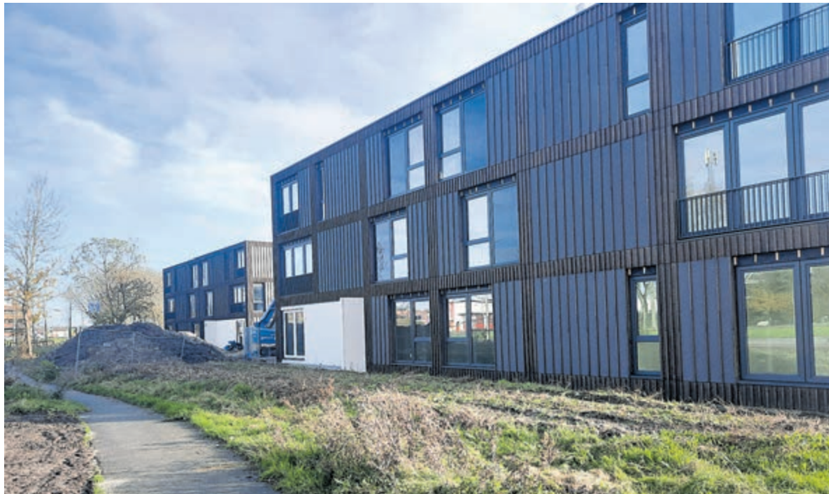
De nieuwbouw van Eigen Haard met totaal 56 sociale huurwoningen naast IKC Triade aan de Dreef/Zwarteweg is bijna klaar voor ingebruikname. De oplevering is gepland in de laatste maand van dit jaar (december).
