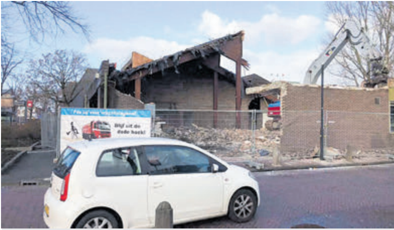
De sloop van het postkantoor aan de Stationsweg. Foto: Oud Aalsmeer
