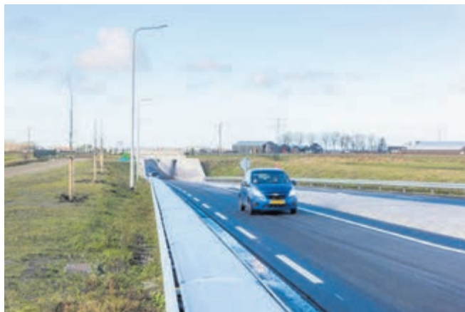
Zonne-energie kan op veel meer plekken: Zonnepanelen in vangrail.
