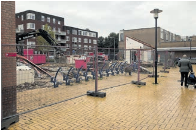
Wie redt de fietsenrekken bij het pand dat gesloopt wordt?
