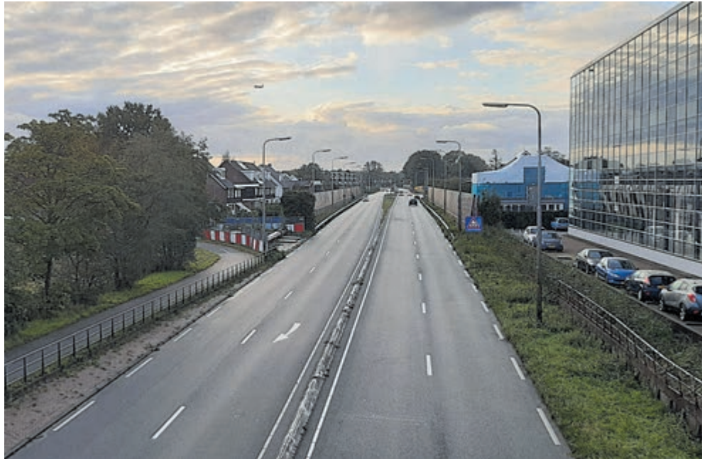
Vanaf 19 oktober gaat de Burgemeester Kasteleinweg dicht tussen de Ophelialaan en de Zwarteweg wegens HOVASZ-werkzaamheden.
