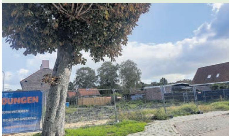
Inmiddels zijn de opstallen van de apotheek in de Kastanjelaan gesloopt.
