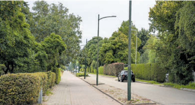
Op 6 oktober starten de dijk- en rioolwerkzaamheden aan de Kudelstaartseweg. Foto: aangeleverd
