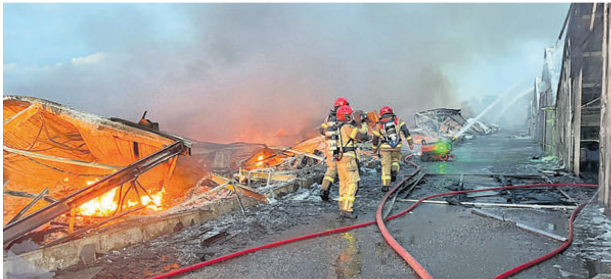
De uitgebrandde loods aan de Oosteinderweg. Foto: Brandweer Aalsmeer
