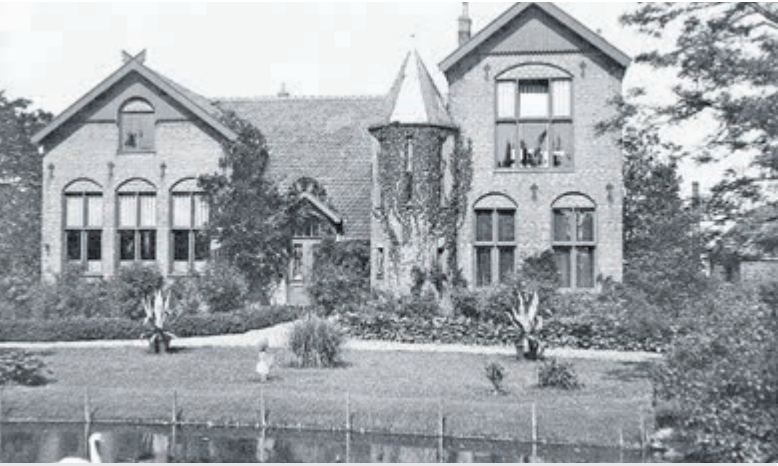
De (allang gesloopte) tuinbouwschool aan de Stationsweg.
