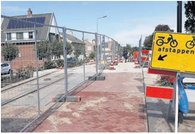
De eerste palen voor de aanleg van de fiets- en voetgangersbrug bij de Aalsmeerderbrug over de Ringvaart zijn geslagen. Foto: Jan Ran
