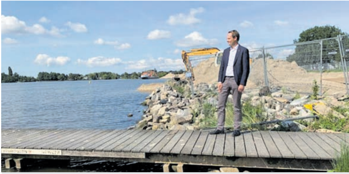
Wethouder Bart Kabout bij de weer opgestarte werkzaamheden aan het Waterfront.
