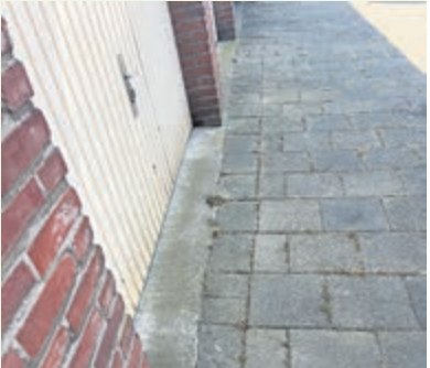
Het trottoir na aanpak door gemeentemedewerkers
