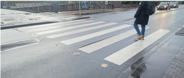
De geïntegreerde knipperlichten bij het zebrapad in Hoofddorp. Foto: aangeleverd
