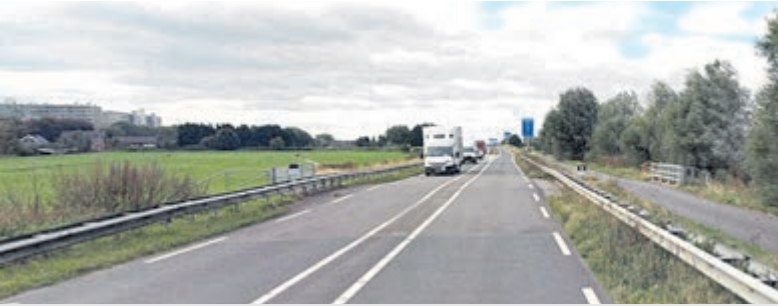
Provinciale weg (N201) bij Uithoorn krijgt nieuw asfalt. Foto: Provincie NH
