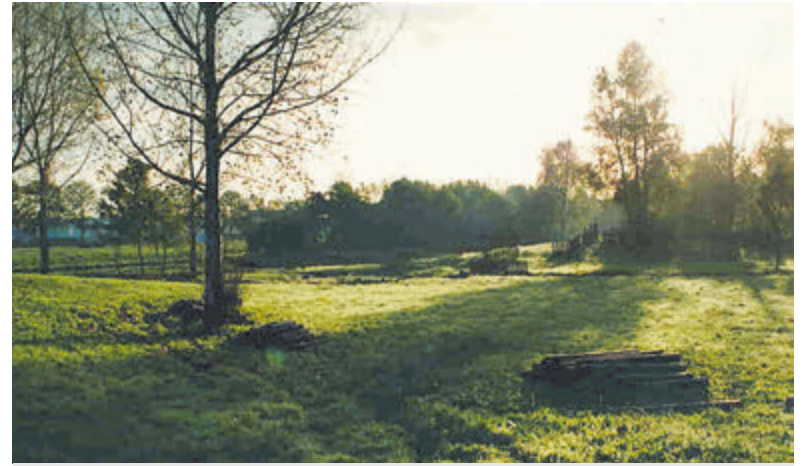
Het terrein wordt bouwrijp gemaakt voor de bouw van de kinderboerderij..
