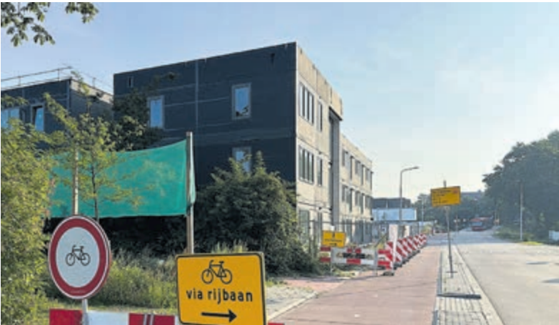
Nieuwe appartementencomplex Ger van Halmhof in aanbouw komt pal aan de straatkant te liggen. Tekst en foto: Joke van der Zee
