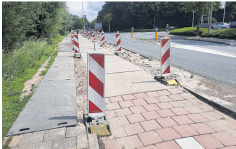
Tijdelijke betonplaten bij het fietspad langs de Zwarteweg. Foto: redactie.
