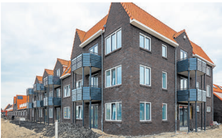
De appartementen aan de Machineweg in aanbouw enkele jaren geleden.
