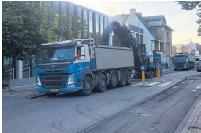
Wegschrapen van de oude asfaltlaag. Foto: www.kicksfotos.nl
