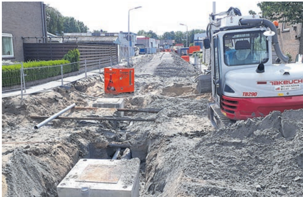
Momenteel wordt hard gewerkt aan het vervangen van de riolering en het herinrichten van de F.A. Wentstraat. De overige straten in de 'blauwe buurt' gaan na deze 'klus' ook groots onder handen genomen worden.
