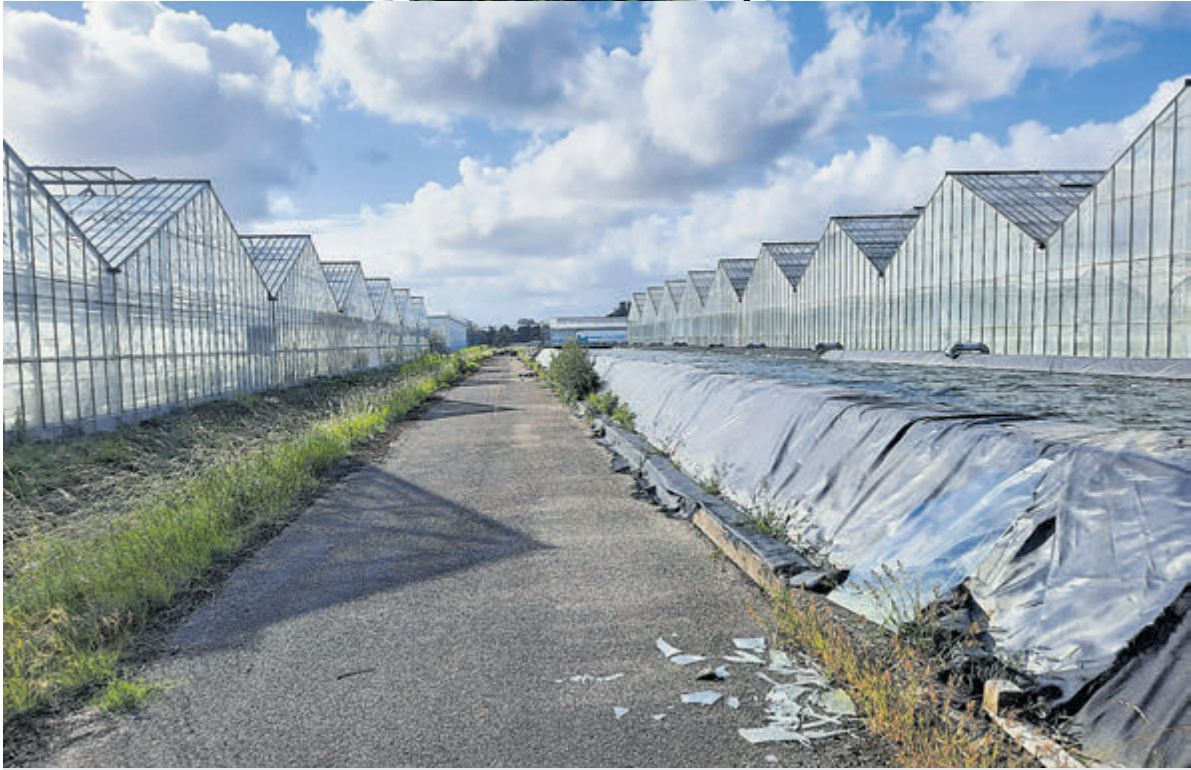
Naast de locatie van het woningbouwplan aan de Mijnsherenweg (percelen tegenover elkaar, links en rechts) staan aan de Hoofdweg nog meerdere kassencomplexen leeg. Foto: Redactie Aalsmeer
